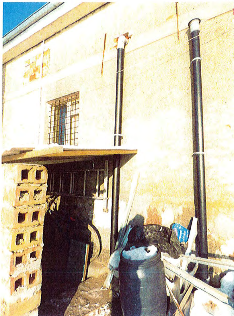
Fot. 5. Elewacja tylna
