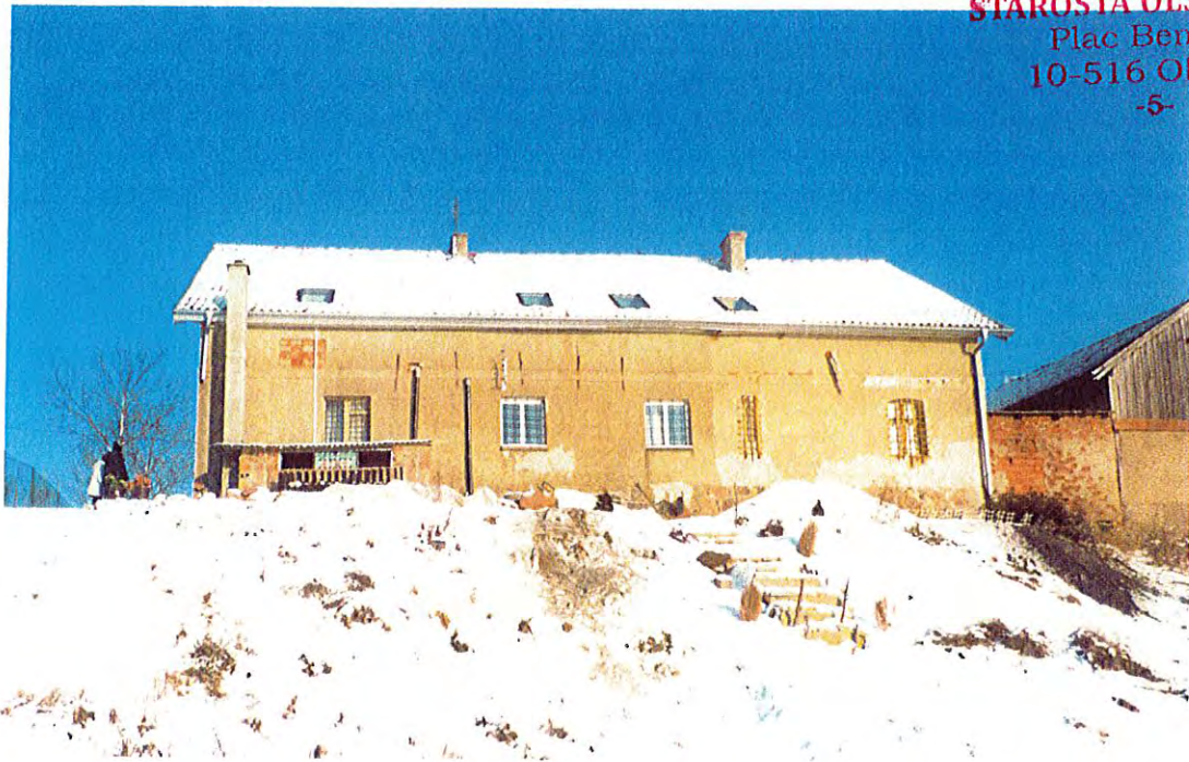
Fot. 3. Elewacja tylna.
