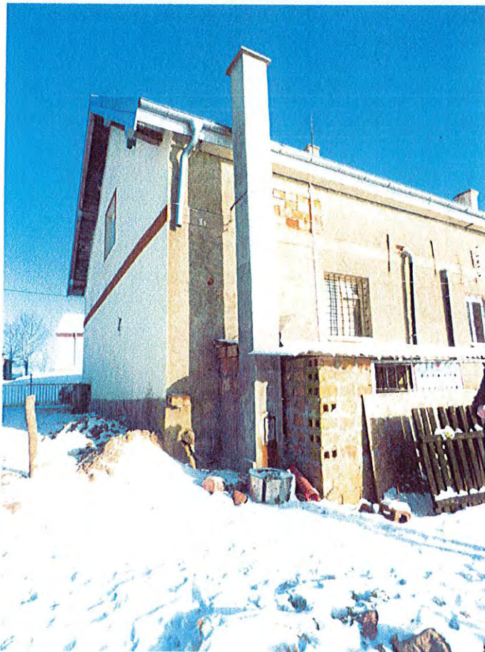
Fot. 4. Elewacja tylna- widok na zejście do piwnicy i wolnostojący komin.
