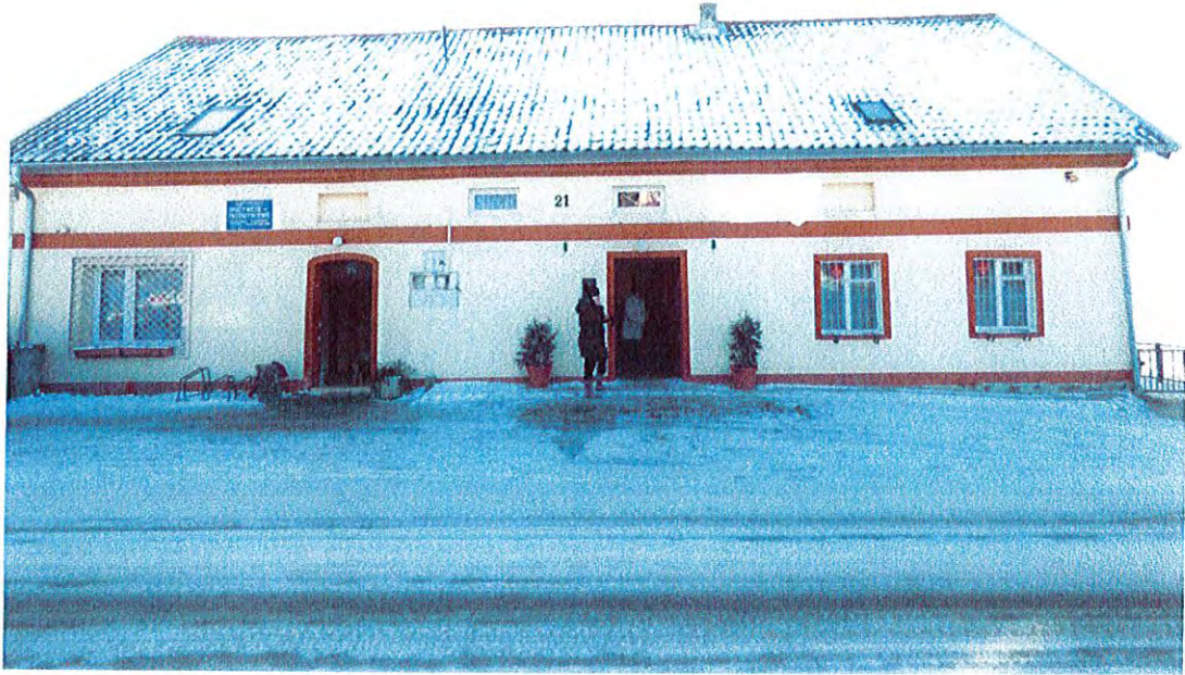
Fot. 1. Elewacja frontowa.
