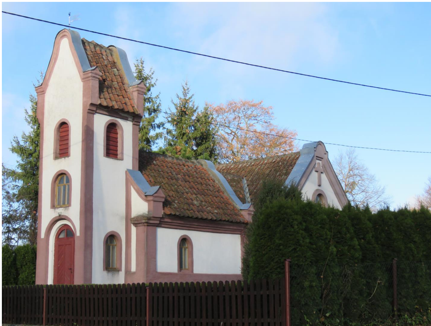
Widok ściany frontowej i wzdłużnej z SE na NW
