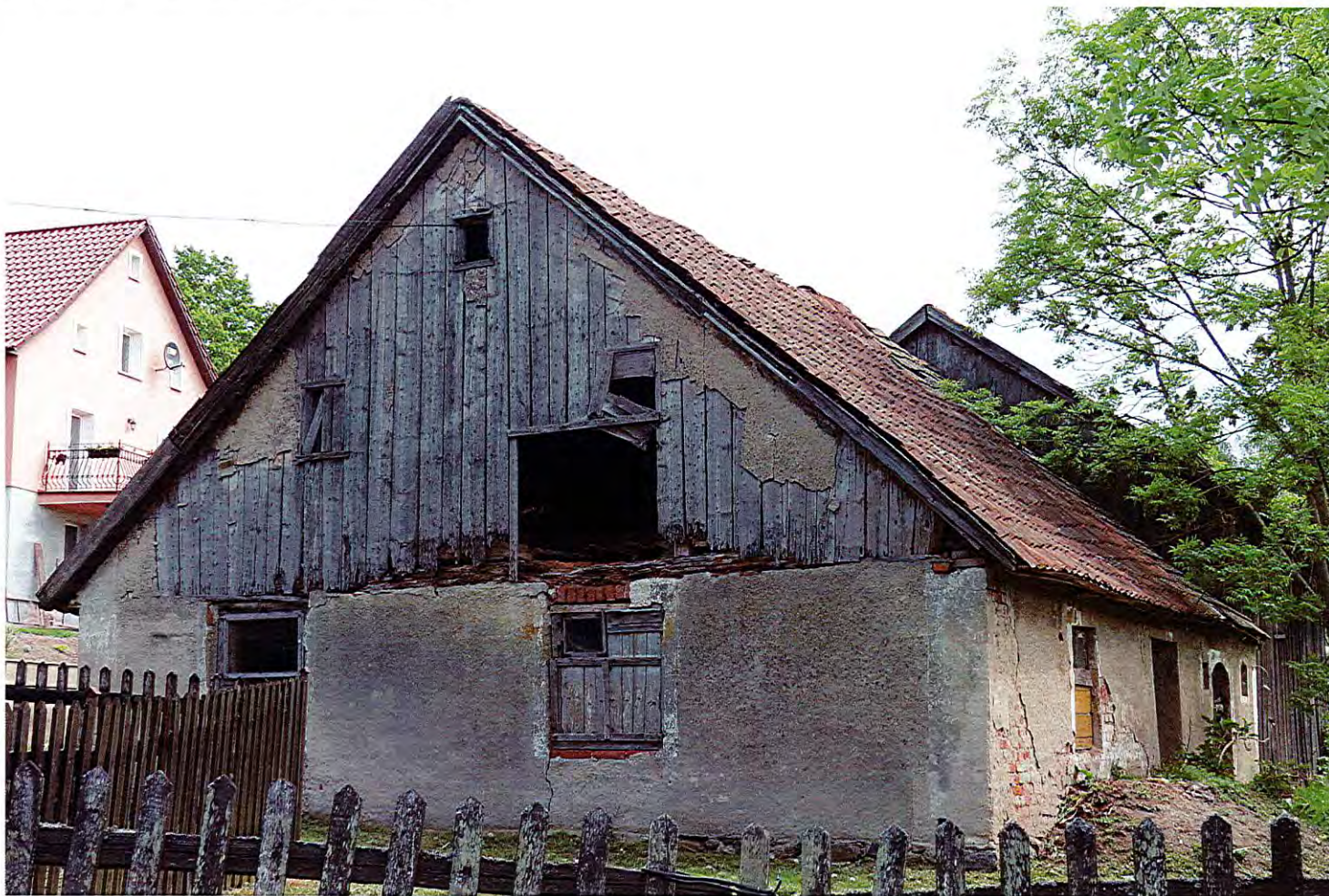
Widok ściany frontowej i szczytowej z SW na NE
