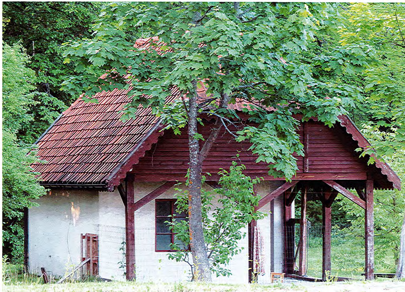
Widok ściany szczytowej i wzdłużnej z W na E
