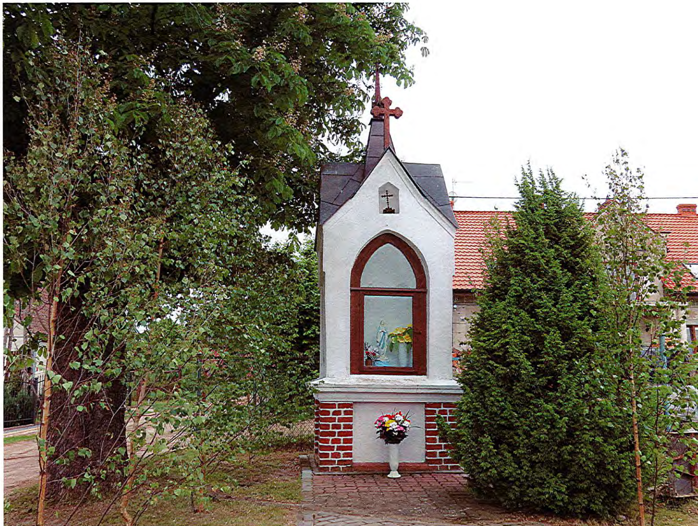
Widok ściany przedniej z SW na NE
