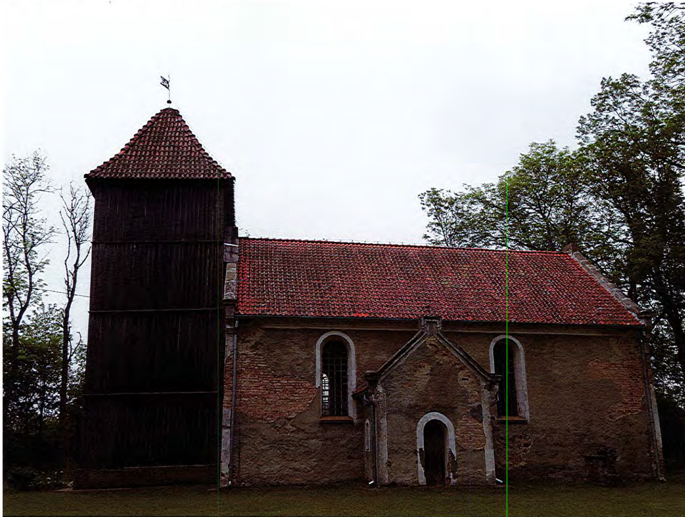
Widok ogólny bryły kościoła z S na N
