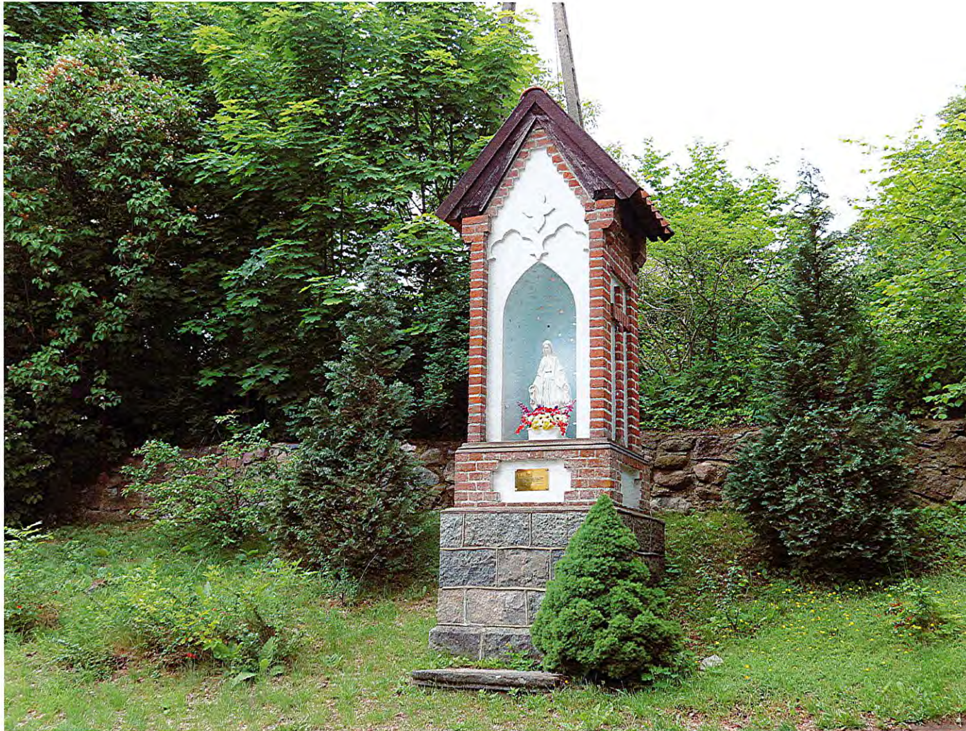
Widok ściany przedniej i bocznej z SE na NW
