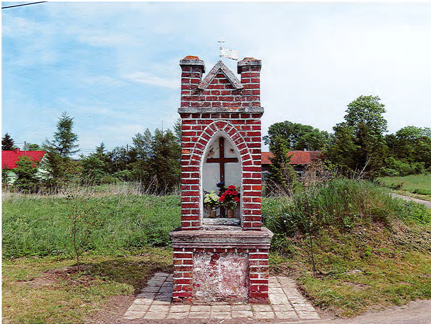
Widok ściany przedniej z SW na NE
