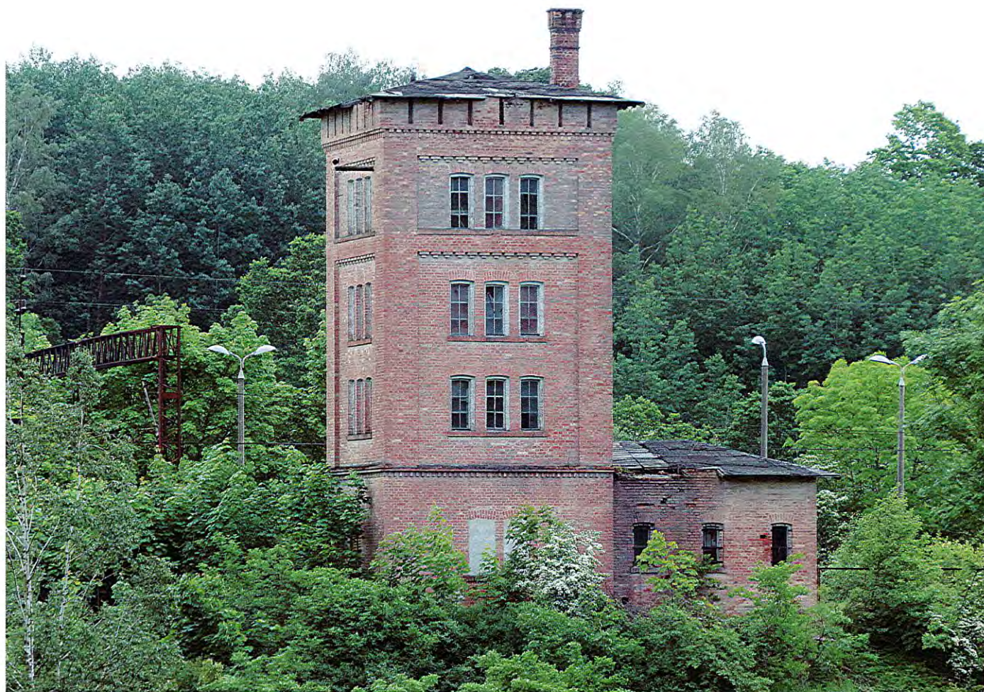
Widok ogólny wieży i stacji pomp z NW na SE
