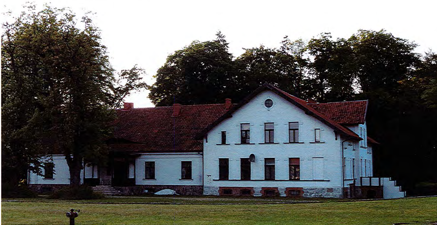
Widok elewacji ogrodowej i bocznej z SE na NW
