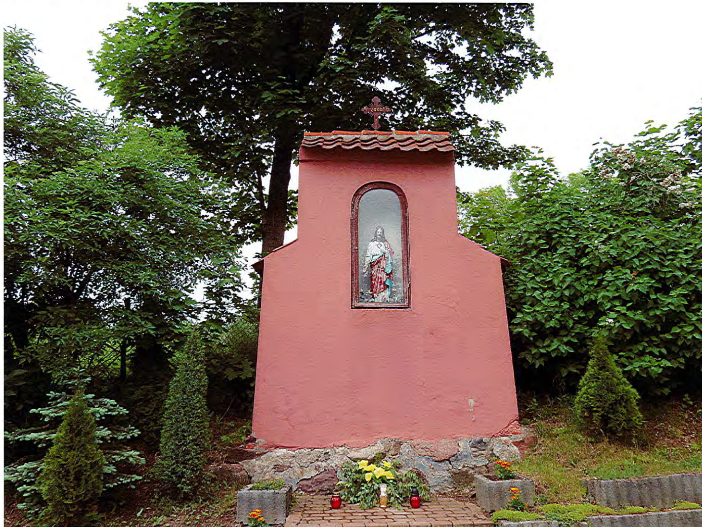
Widok ściany przedniej z NW na SE
