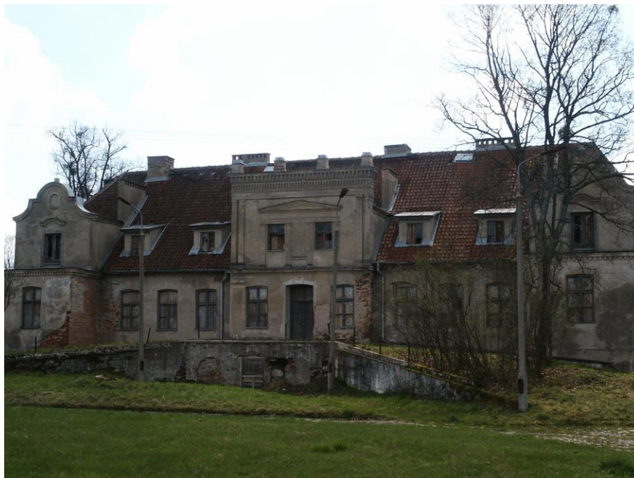
Fot. 4 Górowo. Widok na budynek dworu od strony podjazdu i podwórza gospodarczego
